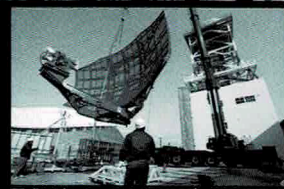
平成19年 ターミナルレーダー建設
