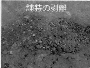
雨水枡角の舗装剥離
