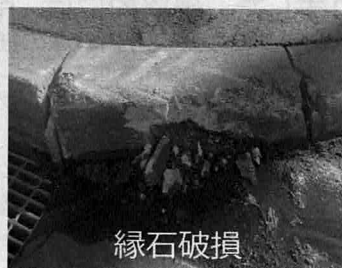
雨水枡角の舗装剥離
